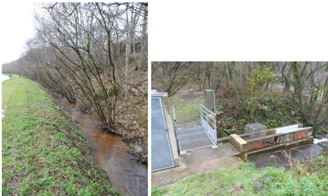
Photo 3 : Passage du Goas Meur à côté des lagunes et comptage en sortie des lagunes
