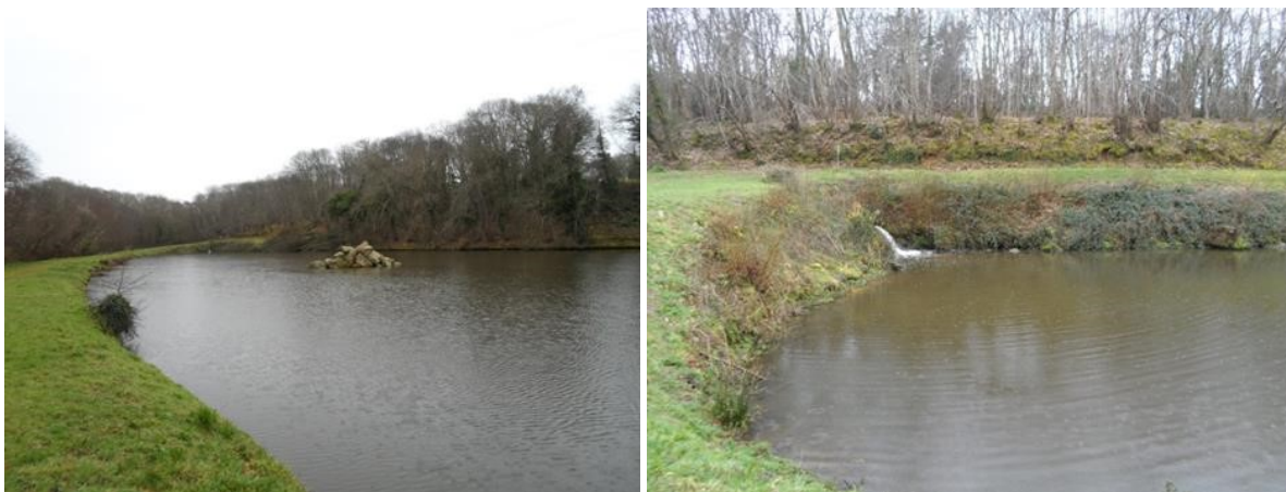
Photo 2 : Vue sur la 1ère lagune et la 2ème lagune
